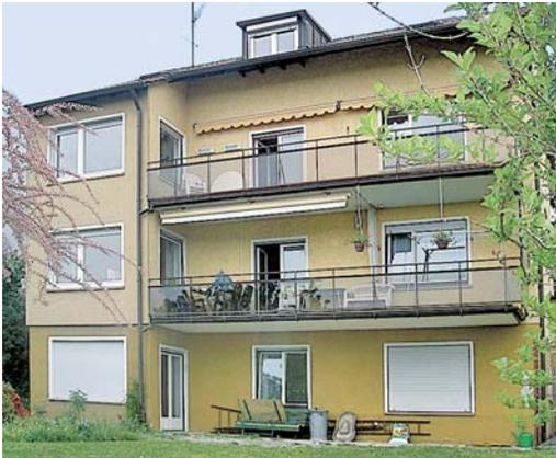
**Abb. D.9.3:** Balkone als Auskragung massiver Geschosdecken wirken wärmetechnisch wie Kühlrippen. Auch eine nachträgliche Dämmung der Kragplatten bringt keinen befriedigenden Erfolg. Abbruch und Ersatz sind hier zumeist die beste Lösung.
