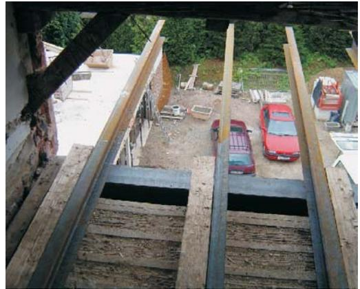
**Abb. D.9.2:** Stahlprofile als Tragelemente für Balkone – Bei der Bemessung der Träger muss die Schwingungsanfälligkeit solcher Konstruktionen beachtet werden. Dabei geht es auch um das Sicherheitsgefühl der Benutzer: Schwingende Balkone machen Angst.
