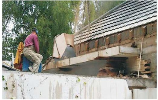
**Abb. D.9.5:** Abtrennen einer Balkonkragplatte in Stahlbeton mit der Bentsäge-technik.
